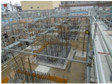
令和5年4月 基礎 鉄筋、型枠工事
