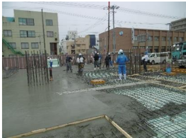
令和5年6月 1階床 コンクリート工事
