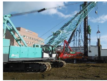
令和4年11月 基礎 杭工事
