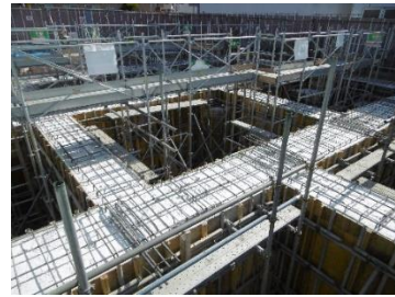
令和5年5月 基礎 コンクリート工事
