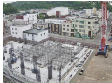
令和5年7月 1階 工事全景
